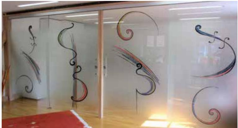
Ganzglasanlage links und rechts Festteile, 2 Türflügel, Glas progressiv gesandstrahlt und mit keramischen Farben handbemalt nach Kundenwunsch
