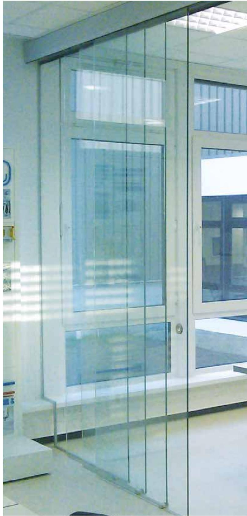
Automatiksystem für Metallglas-Teleskopschiebetüren, 3/4 Läufig
