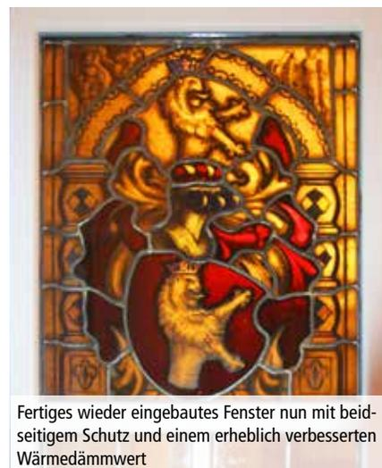
Fertiges wieder eingebautes Fenster nun mit beidseitigem Schutz und einem erheblich verbesserten Wärmedämmwert
