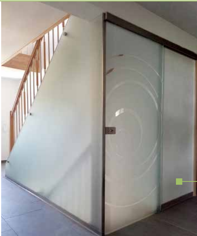
Treppenverglasung mit Schiebetür, sandgestrahlt
